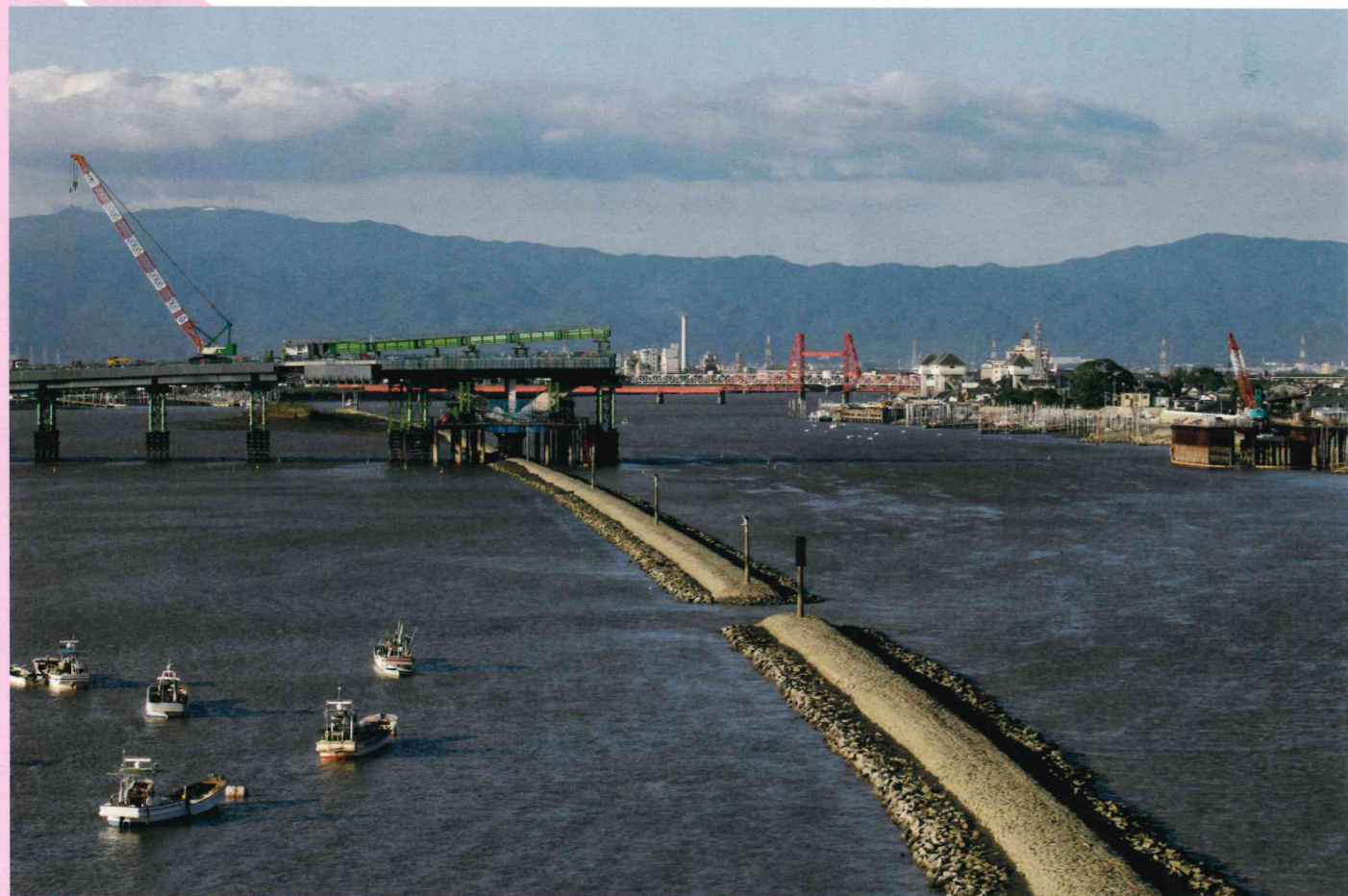
【有明海沿岸道路・筑後川橋（仮称）建設中】
