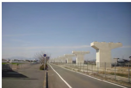
▼整備が進む有明海沿岸道路
