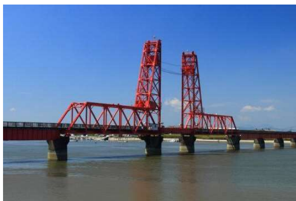
筑後川昇開橋
